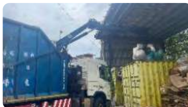
1 於台林廠區現場進行清運
